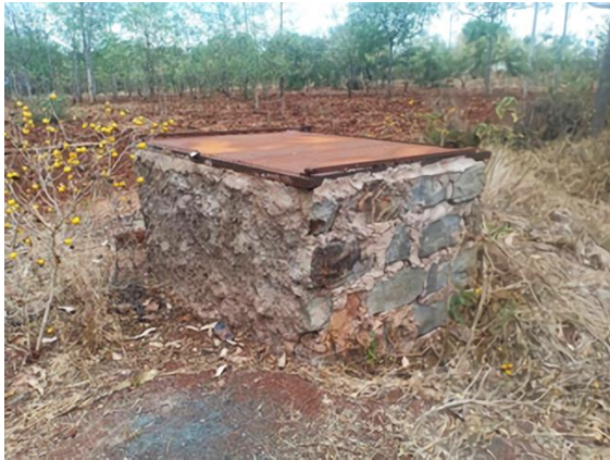
設備設置前の井戸の様子
