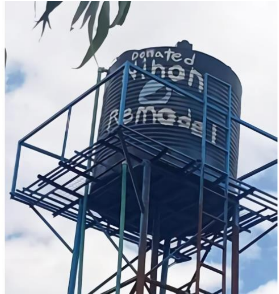
引き揚げた水を貯水するタンク
